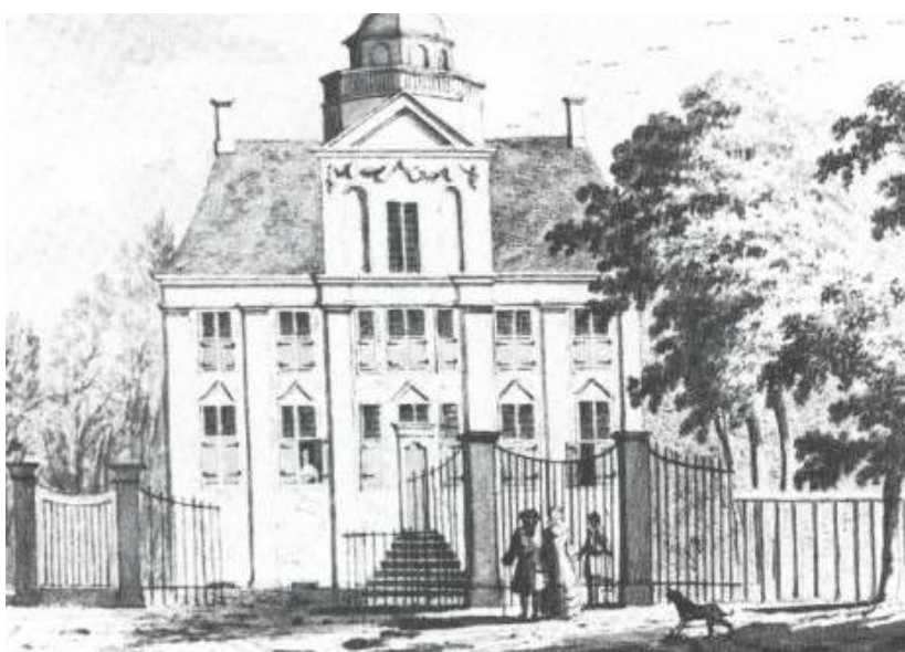
24. De Crackstate te Heerenveen, gebouwd in 1648 heeft met zijn Vingboonsgevel de nodige overeenkomsten met Oldengaerde. Op deze prent van Cornelis Pronk uit 1754 valt op dat dit gebouw nog kruisvensters had in een tijd dat die bij Oldengaerde al lang waren vervangen door schuifvensters. Later kreeg de Crackstate alsnog (empire)schuifvensters.
