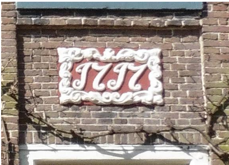
25. Hoezo 1717? Deze zwierige gevelsteen draagt alle kenmerken van de rococo, die pas ruim twintig jaar later in zwang kwam. Het verdiepte gevelvlak – dat niet voorkomt op de tekening van Pronk – heeft drieklezoren op de hoeken, terwijl in de pilasters en het middenrisaliet klisklezoren zijn gebruikt, een oudere metselwijze.
