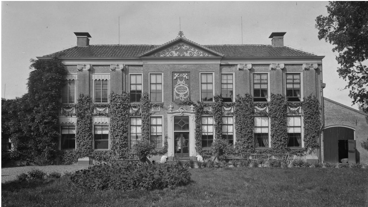
17. Op deze foto uit ca. 1900 zijn de uitgebouwde bouwdelen ter weerszijde van het pand nog niet voorzien van de gegolfde gevelbeëindiging. Vier vensters links bezaten markiezen, blijkbaar noodzakelijk vanwege een ongunstige zoninval; restanten van de bevestigingshouten zijn tegenwoordig nog in de kozijnen waarneembaar. Opmerkelijk zijn verder de drie bliksemafleiders.
